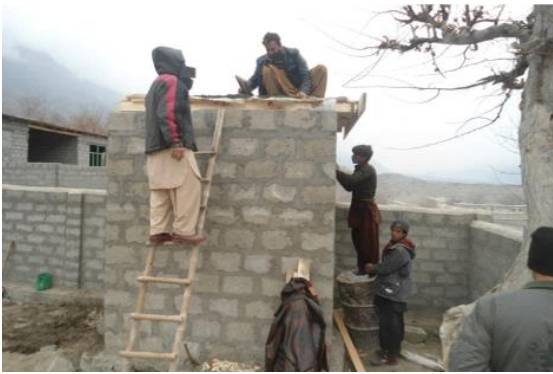
上：学校の建設を手伝う村人 右：OLSS の生徒たち (写真提供 OLSS)
